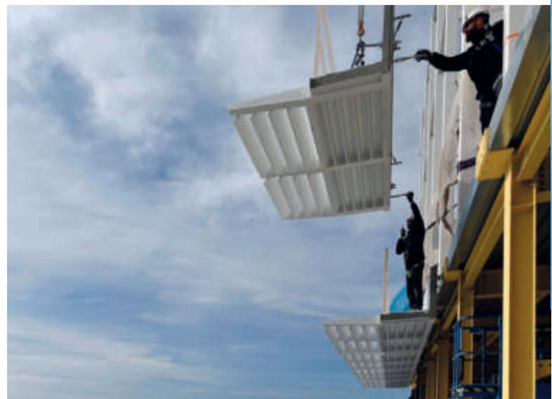
Marseilles neue Hochhausfassaden bestehen aus vorgefertigten UHPC-Fertigteilelementen, die zu Wärmedämmung, Sonnenschutz, Gebäudeinstandhaltung und Brandschutz beitragen.
