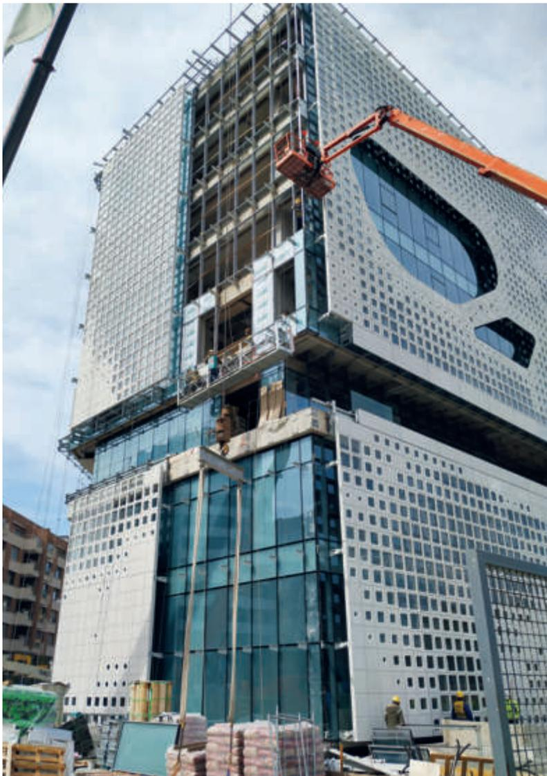
Für die äußere Hülle der Fassade entschieden sich die Architekten, die konstruktiven und gestalterischen Möglichkeiten von UHPC zu nutzen, mit Hilfe derer sich eine bildgebende Perforation der Elemente erzielen ließ. Für dieses Projekt wurde eine Lösung aus weißem UHPC mit Fasern aus Edelstahl (E304-Fasern, 14 mm / 0,2 mm) verwendet. Die Perforationen auf den UHPC-Fassadenplatten wurden mit fest verbauten, tragenden Glaselementen versehen.
