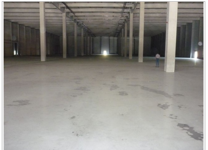
Deckenbinder und Bodenplatte in Stahlfaserbeton
