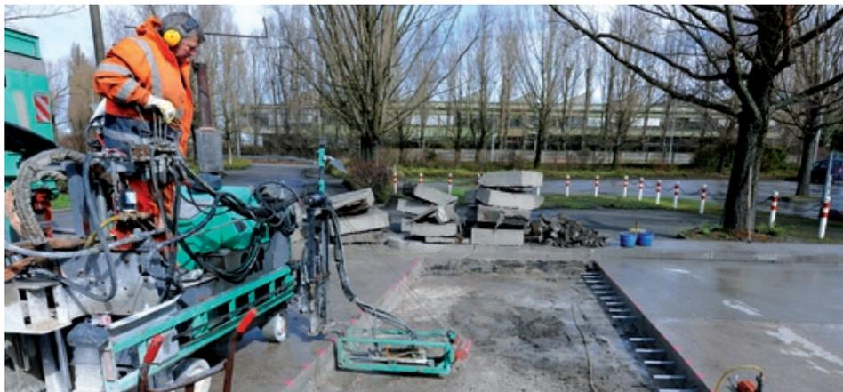
Unter ebenfalls ungünstigen Witterungsbedingungen wurden am letzten Märzwochenende bei strömendem Regen zwei Betonplatten in der Zufahrt zum Zementwerk Leimen ausgetauscht. Der Beton wurde von Heidelberger Beton Eppelheim geliefert und von der Firma Otto-Alte-Teigeler GmbH eingebaut. Trotz der widrigen Bedingungen konnte der Beton wie geplant eingebaut und nach 5 Stunden für den Werksverkehr freigegeben werden.
