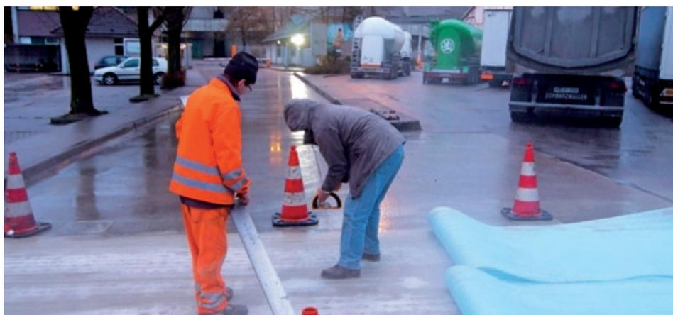
Abbildung 2: Plattenaustausch auf der Zufahrt zum Zementwerk Leimen
