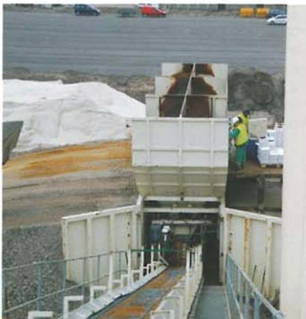
Bild 10: Zugabe der Stahlfasern auf ein Förderband
