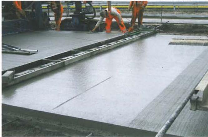
**Bild 12: Herstellung einer faserfreien Oberfläche**
