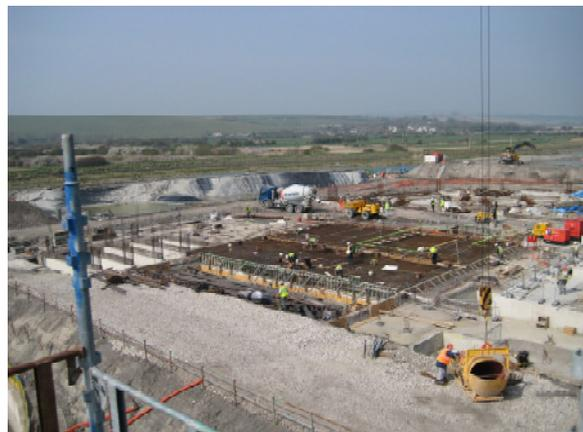
chemischen und mechanischem Angriff ausgesetzt sind. Aus diesen Gründen war auch eine Begrenzung der Rissbreite nachzuweisen. Um die dafür erforderliche große Menge an Baustahl möglichst gering zu halten, entschied sich die Firma Hochtief Construction AG für eine Kombilösung aus stahlfaserverstärktem Stahlbeton. Durch den Einsatz von 40 kg/m<sup>3</sup> einer mittelfesten Drahtfaser mit der Länge 60 mm
