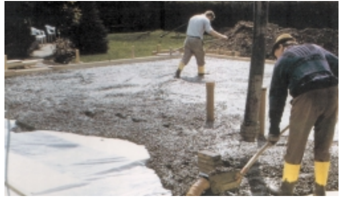
Bild 20: Bodenplatte im Wohnungsbau unter Einsatz von Stahlfasern
