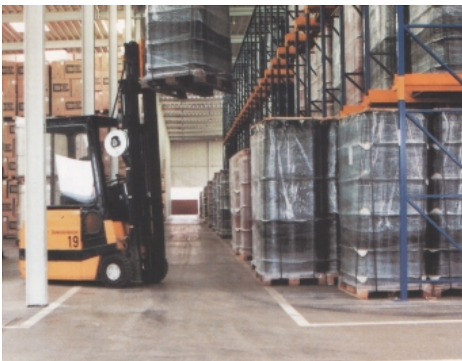
Bild 13: Fußboden mit Stahlfaserbeton bei einer Lagerhalle
