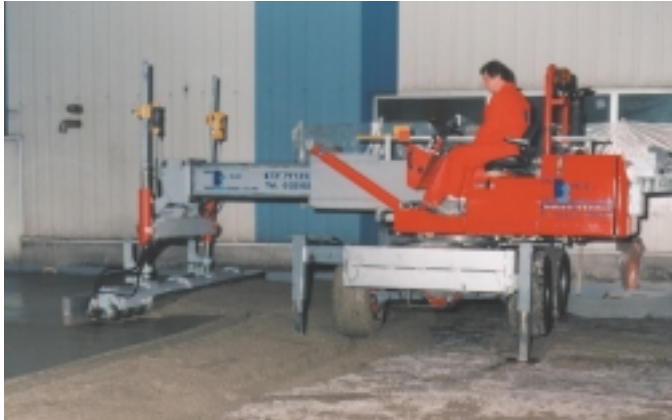
Bild 15: Einsatz eines Laser Screeds
