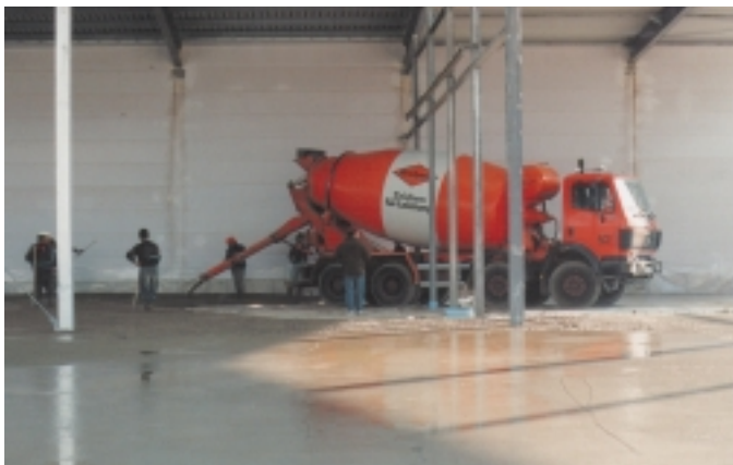
Bild 16: Einbau von Stahlfaserbeton bei der Herstellung eines Industriefußbodens
