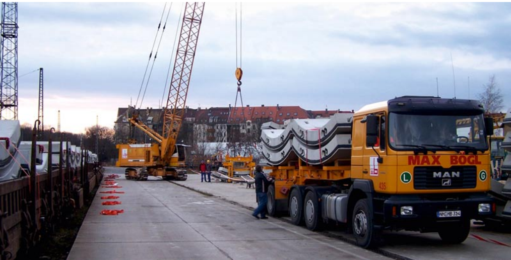
Tübbinganlieferung am City-Tunnel Leipzig
